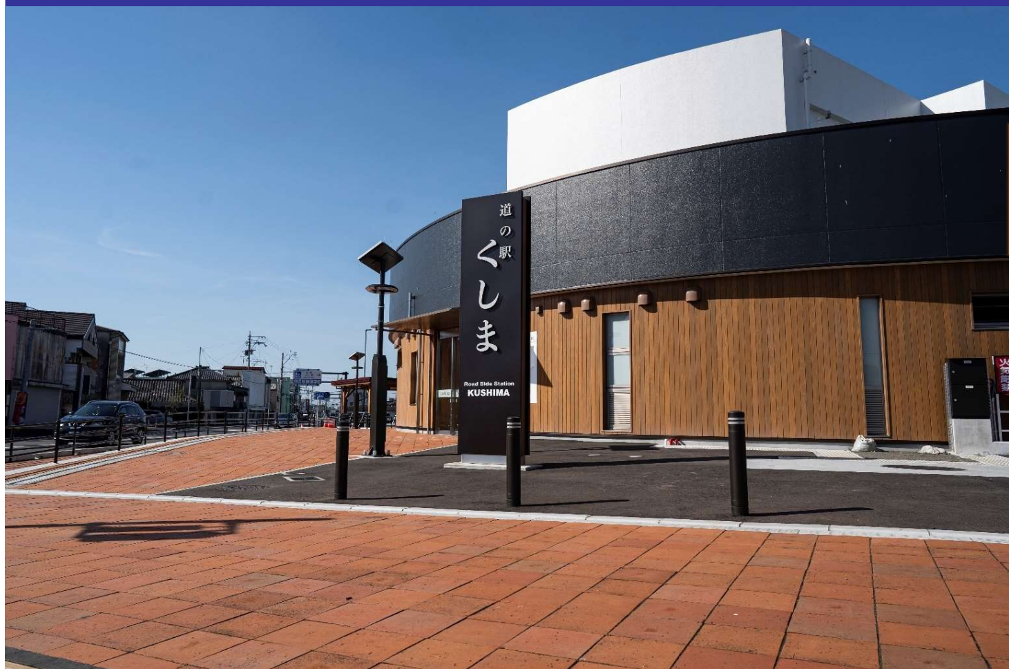
宮崎河川国道事務所 宮崎県串間市 道の駅くしま 外構 品名：新燃れんが 寸法：300×300×50、60
