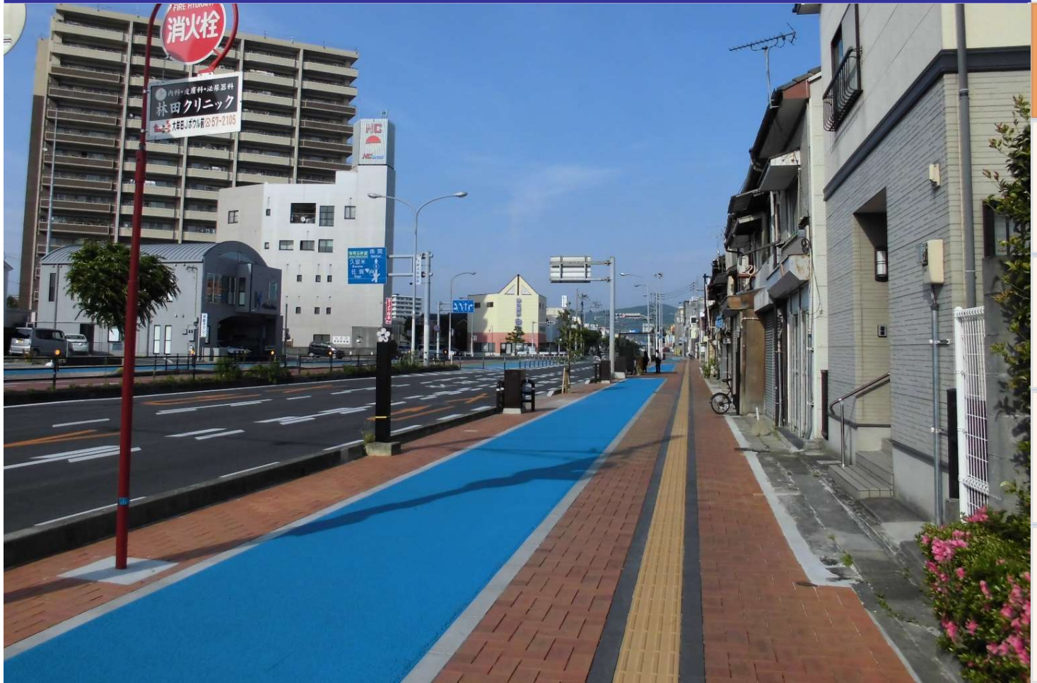
福岡国道事務所 福岡県大牟田市 国道208号線/大牟田地区 品名：新燃れんが 寸法：230×115×50、60
