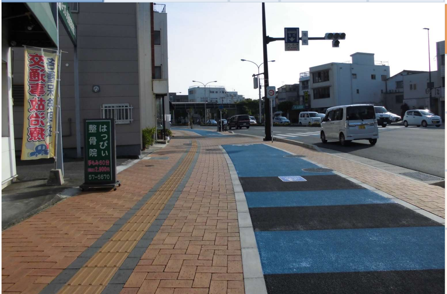
福岡国道事務所 福岡県大牟田市 国道208号線/大牟田地区 品名：新燃れんが 寸法：230×115×50、60
