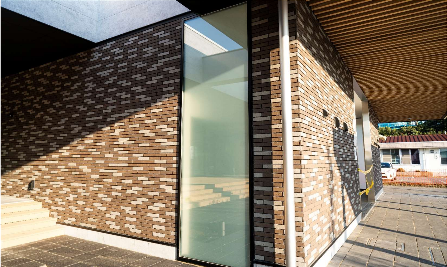
都城市 道の駅都城 外壁
