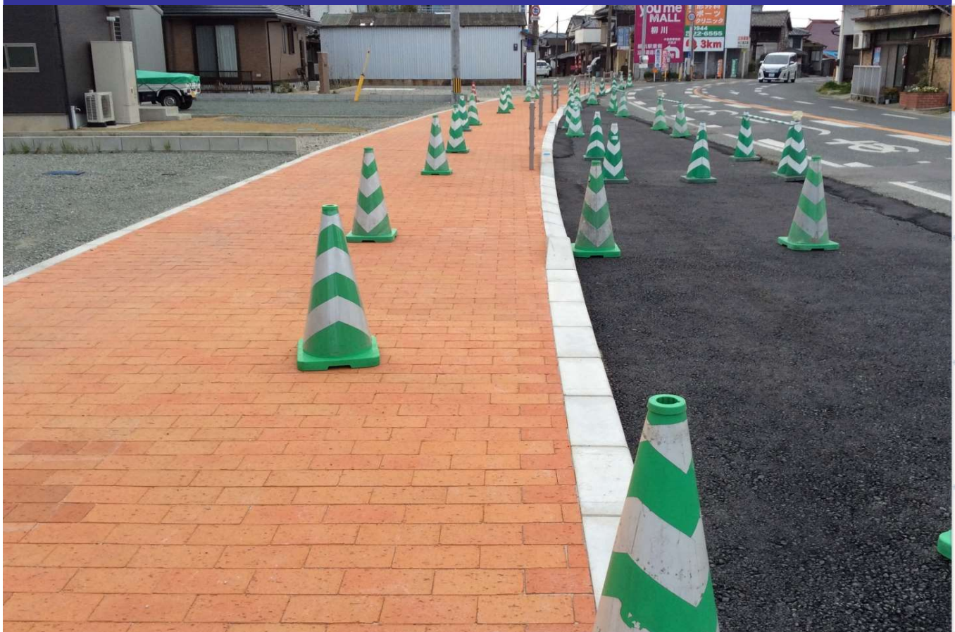
福岡国道事務所 福岡県大牟田市 国道208号線/中島地区 品名：新燃れんが 寸法：230×115×50、60
