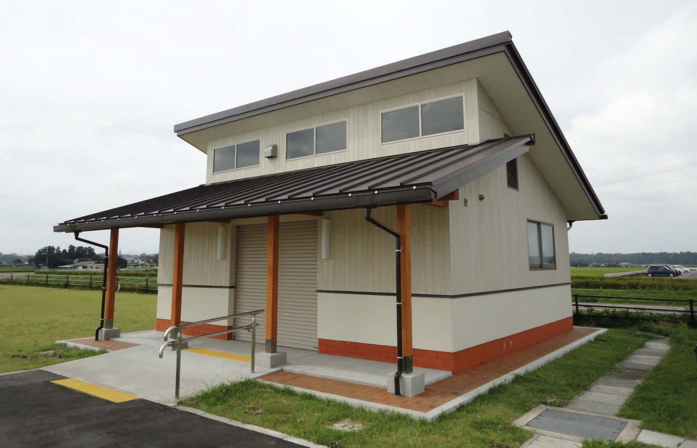
都城市役所 都城市郡医師会病院前駐車場トイレ 品名：71ト'230寸法：230×115×50・品名：ルネッサンス(外壁)寸法：235×92×15
