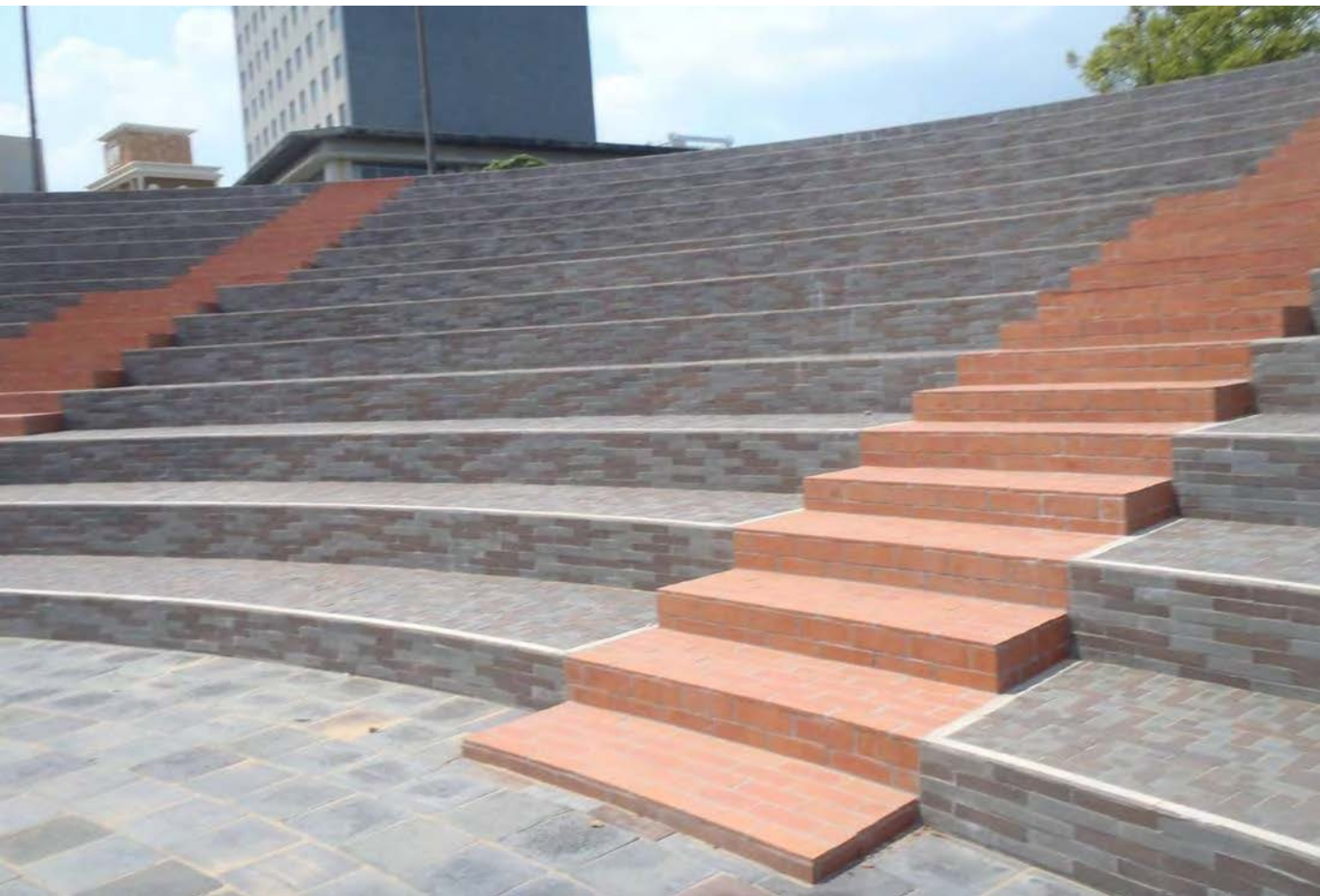
九州地方整備局宮崎河川国道事務所 高洲地区特殊耐震補強工事5工区：品名：ホーター 寸法：46×235×15
