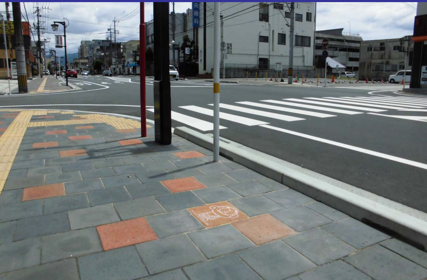
都城市役所 母智丘通線歩道
