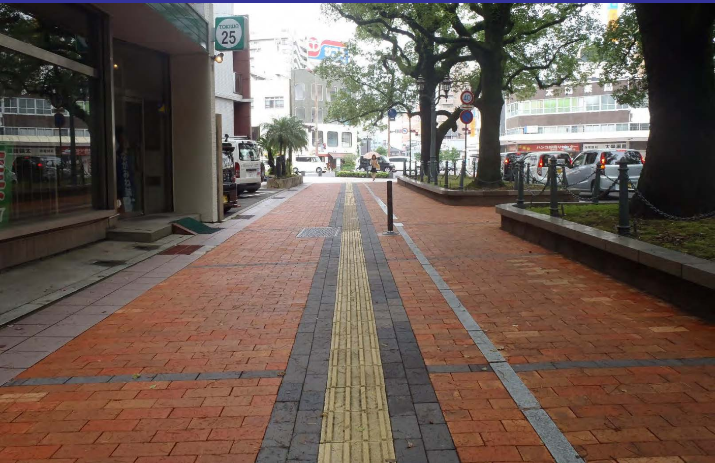
宮崎土木事務所 平成25年度県単維持第01-01-39号県道宮崎島之内線橋通東工区歩道平板ブロック張替補修工事 品名：ワイド230 寸法：230×115×50
