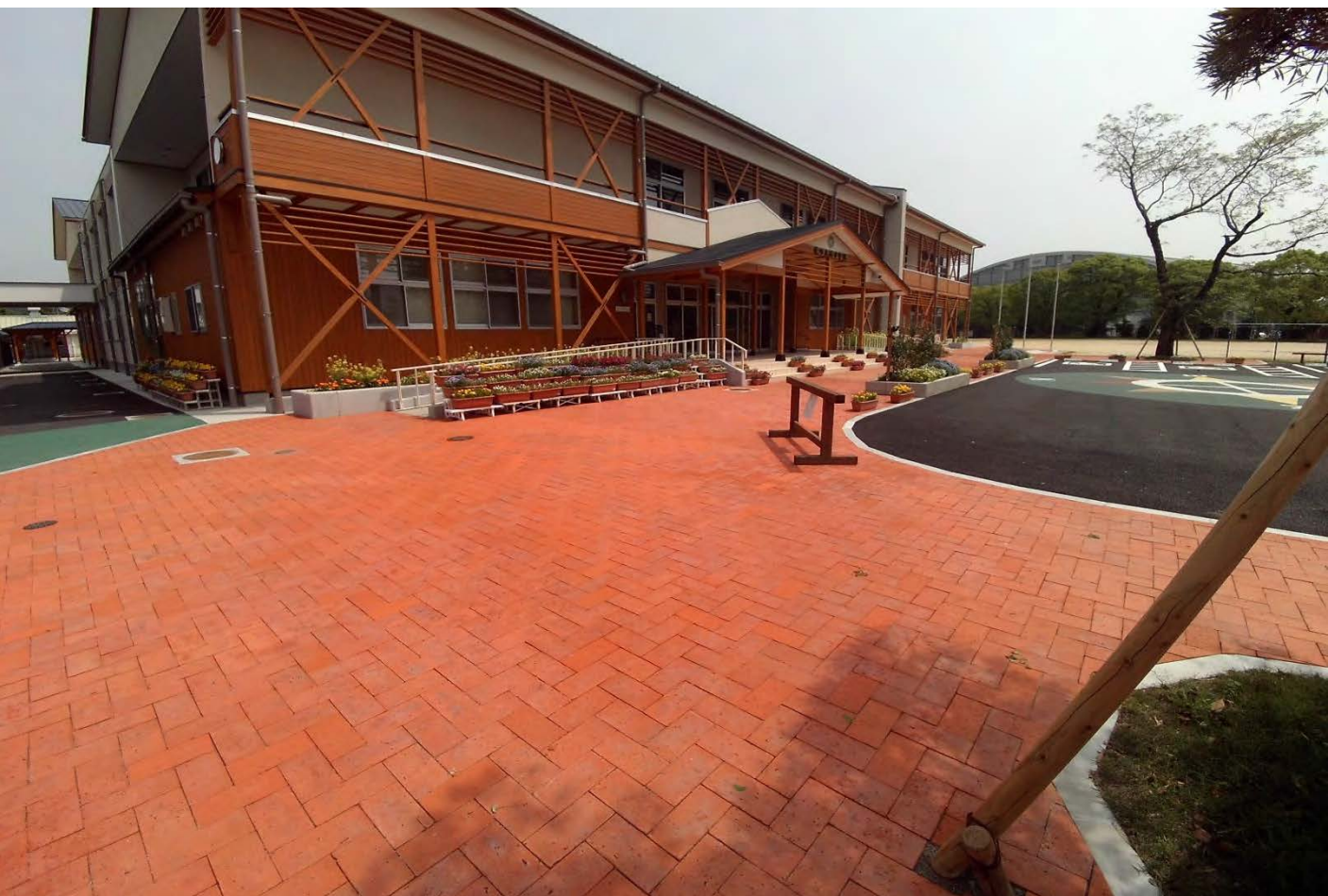
綾町役場 綾中学校駐車場整備 品名：71卜'230 寸法：230×115×50
