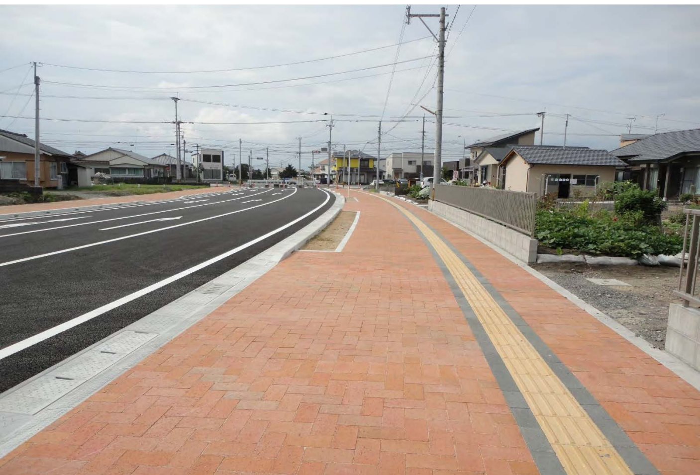
都城市役所 鷹尾上長飯通線(郡元工区・5工区)道路改良工事 品名：71卜'230 寸法：230×115×50
