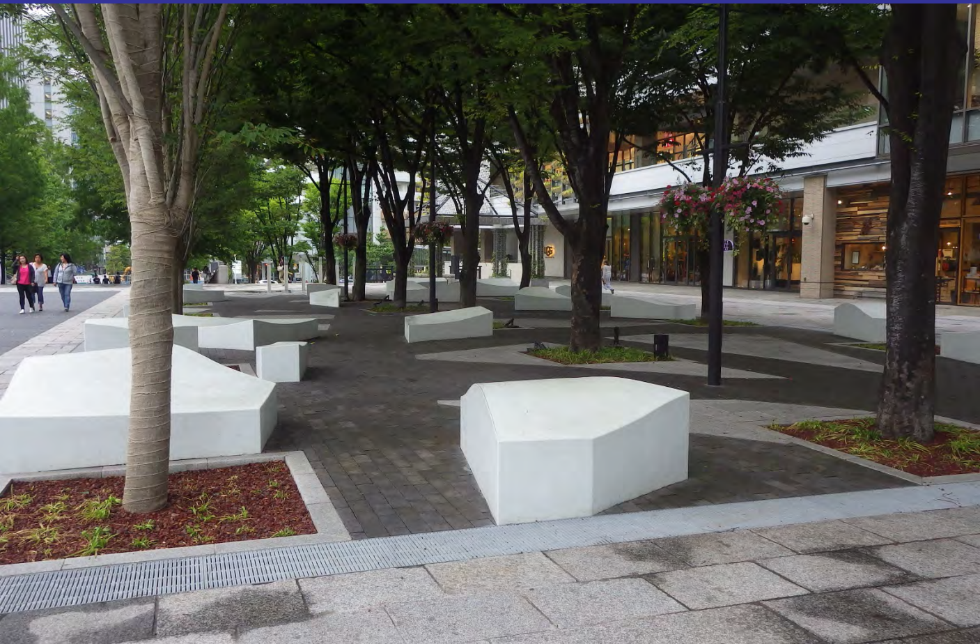
横浜市 グランモール公園再整備工事
