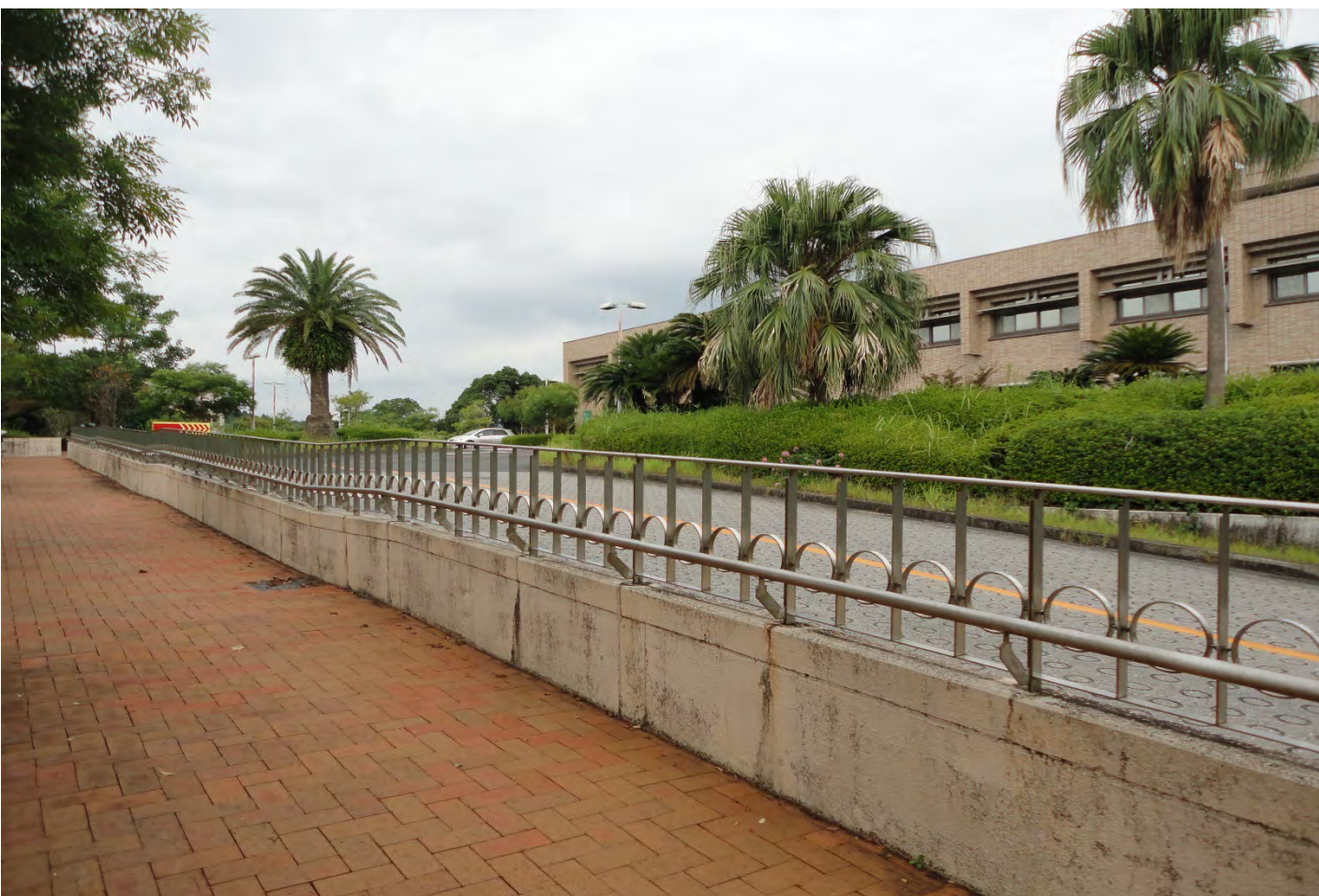
宮崎県庁病院局 県立日南病院外部歩道 品名：ワイド230 寸法：230×115×50
