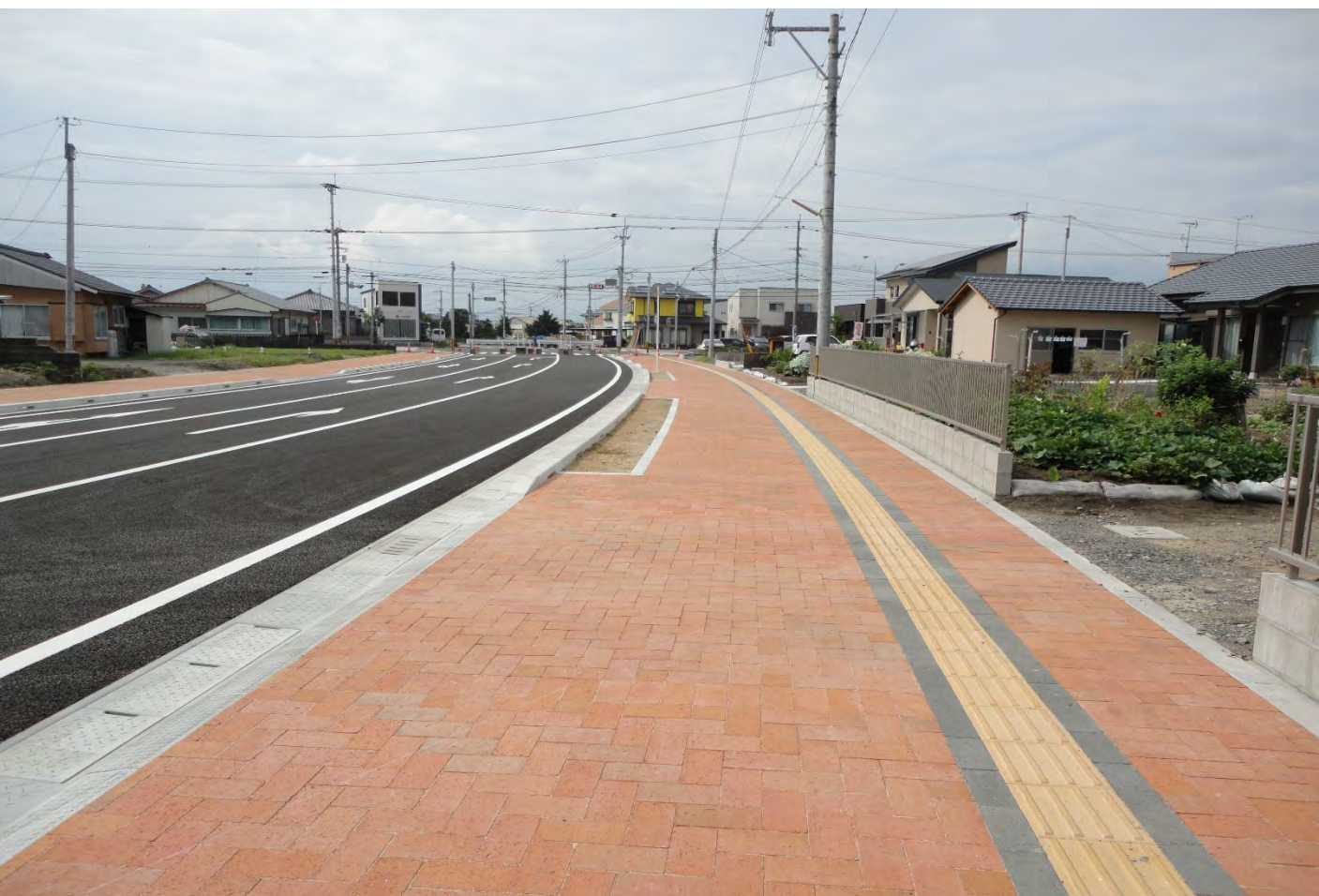
都城市役所 鷹尾上長飯通線(郡元工区・5工区)道路改良工事 品名：71ト'230 寸法：230×115×50
