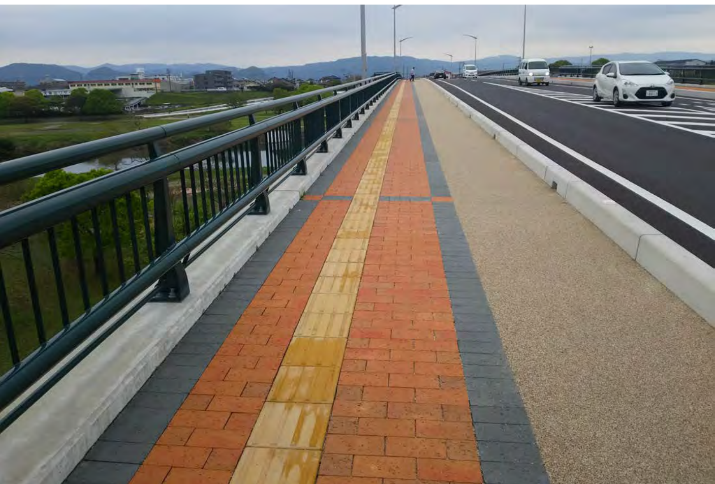
霧島市役所（鹿児島県） しらさぎ橋 品名：霧島ECOれんが 寸法：230×115×40
