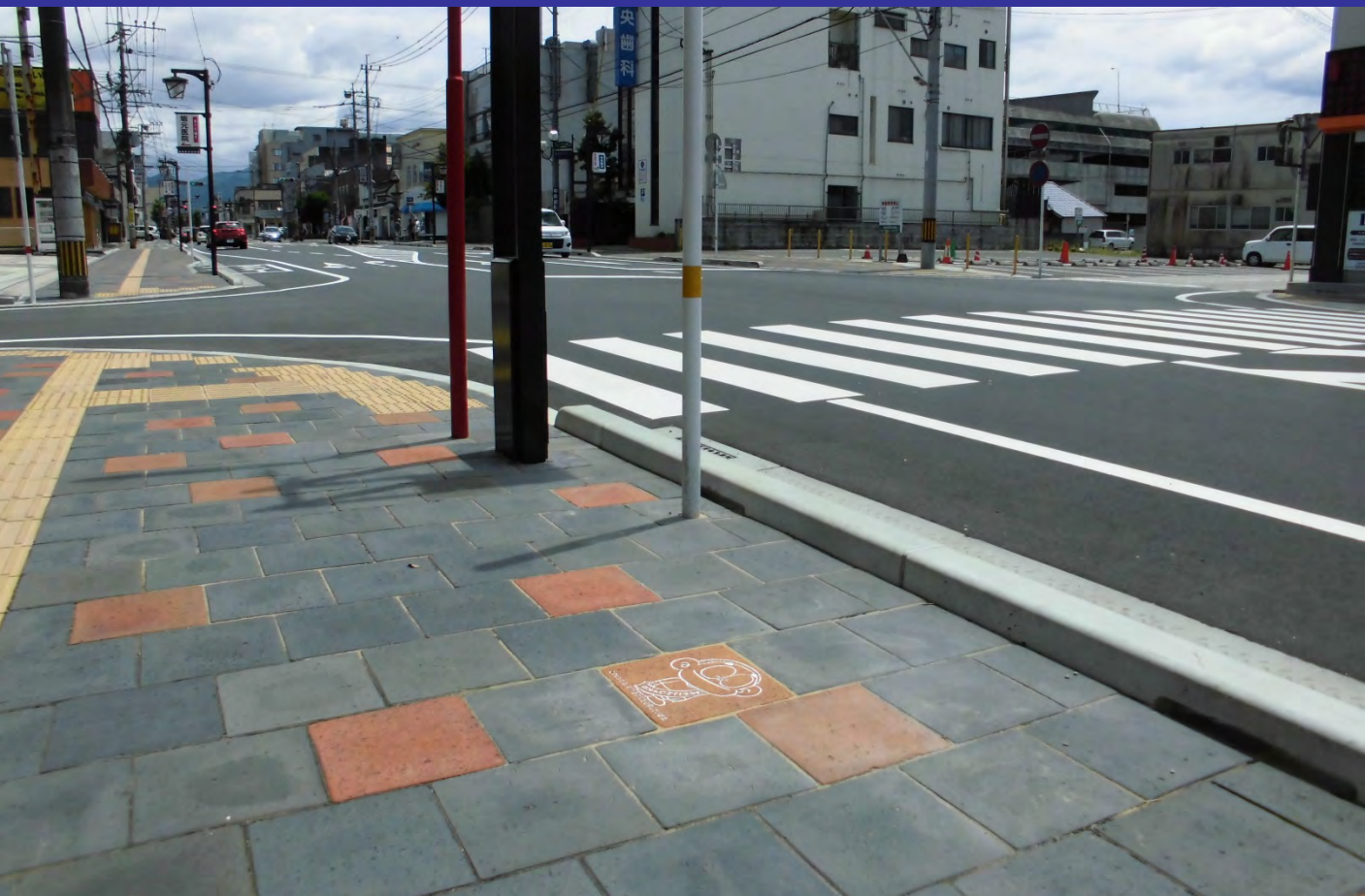
都城市役所 母智丘通線歩道
